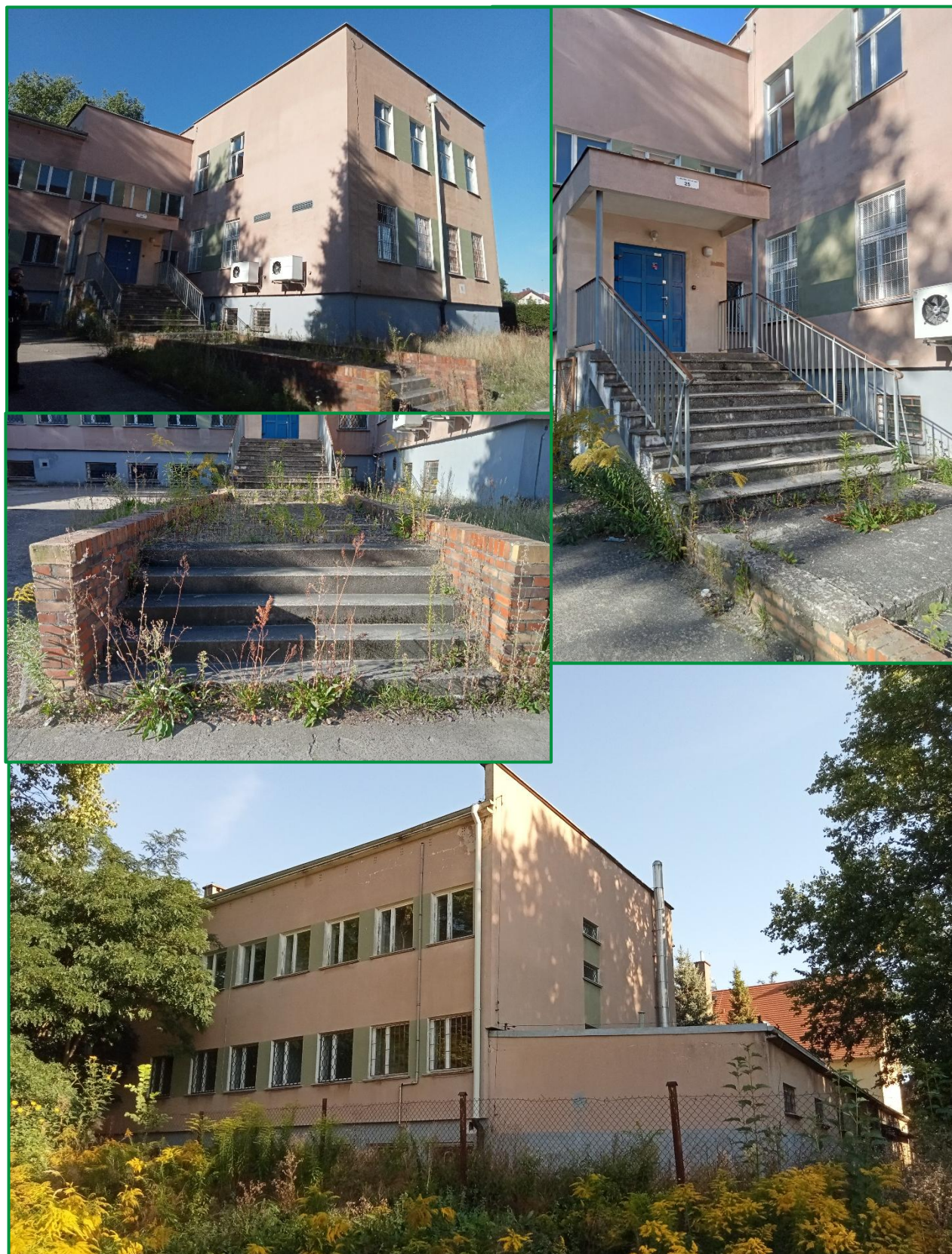
Rycina 20 Budynek dawnej telekomunikacji w Rzepinie, ul. Wojska Polskiego 25A
